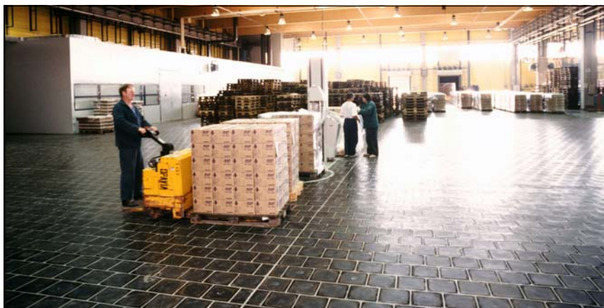
Hladká dlažba výrobní haly potravinářského provozu (250/250/22JR)
