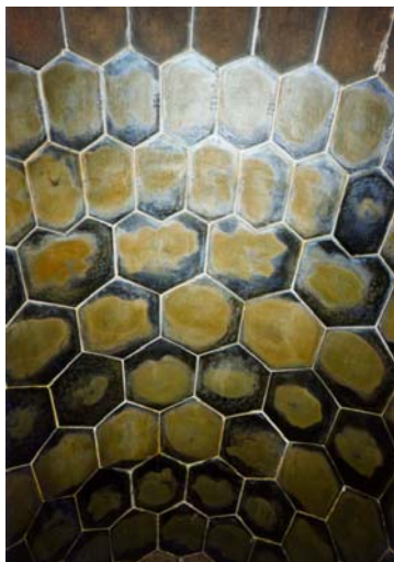
Čedičové vyložení cyklónu v cementárně
