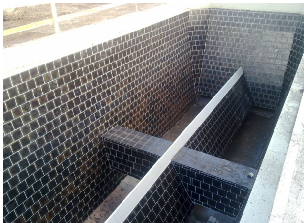
Hladká dlažba jako obložení hlubinného zásobníku na uhlí
