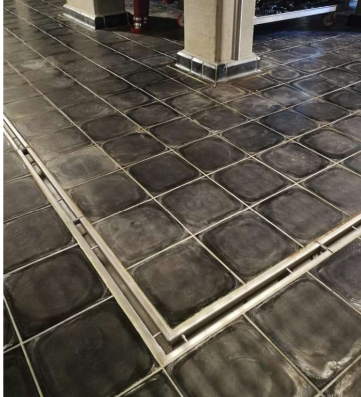
Obložení sloupů, odvodnění podlahy, vinařství Itálie
